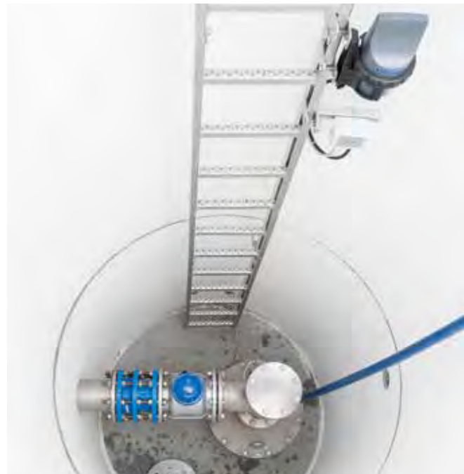
Point de mesure IP68 autonome avec communication GSM/GPRS
