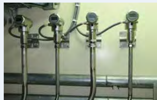
Mesure de niveau TDR sur eau de condensation en milieu irradiant
