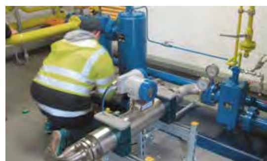
Système de remplissage de navires pour le gaz liquéfié selon MID MI-005
