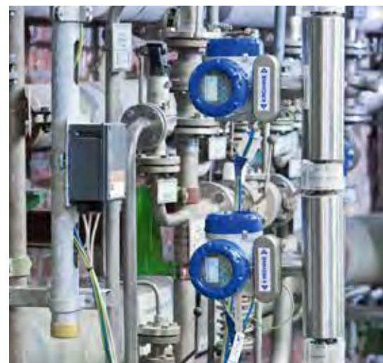
Débitmètres à effet Coriolis à tube droit dans une application de sécurité
