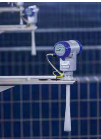
Mesures de niveau dans les installations d'adduction d'eau
