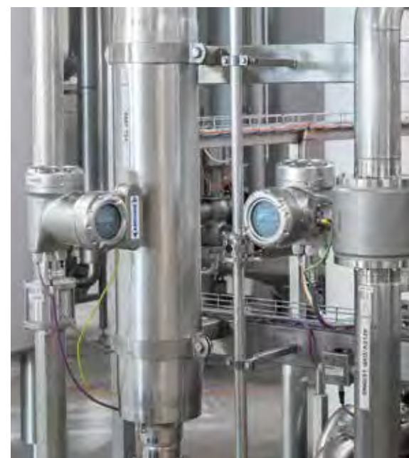
Débitmètre massique à tube droit OPTIMASS pour produits sensibles au cisaillement
