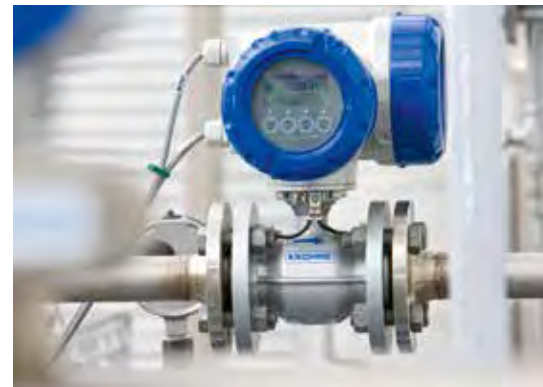
Référence virtuelle pour les DEM : les disques de masse deviennent redondants
