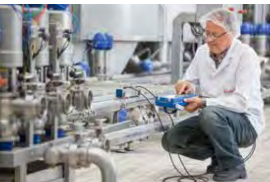
Mesure de débit temporaire avec débitmètre pour montage externe dans une laiterie
