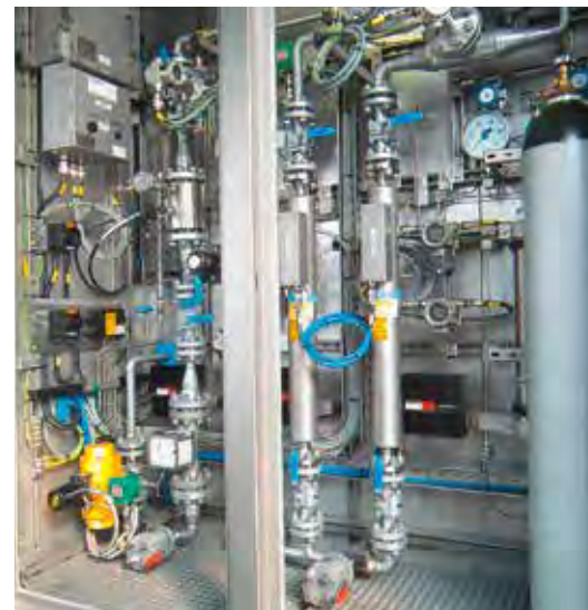
Abris pour analyseurs de skids de comptage transactions commerciales
